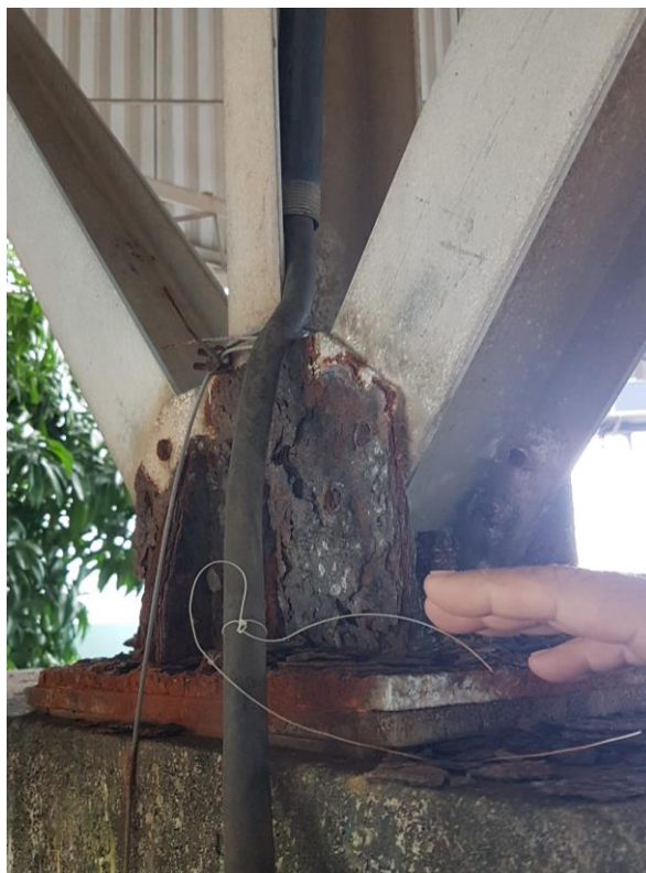
Figura 3 – Foto tirada in loco da estrutura metálica da cobertura. Fonte: COPROJ-SEINF.
