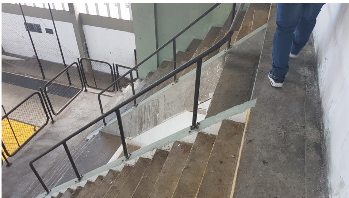
Imagem 04 – Foto tirada in loco do guarda-corpo na arquibancada superior que está fora de norma.
