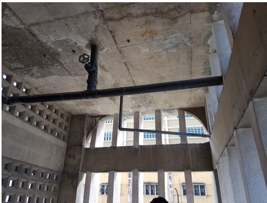
Imagem 07 – Foto tirada in loco da laje abaixo da caixa d’água sul. Fonte: COPROJ-SEINF.
