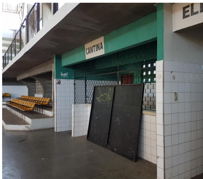
Imagem 16 – Foto tirada in loco da cantina existente. Fonte: COPROJ-SEINF.
