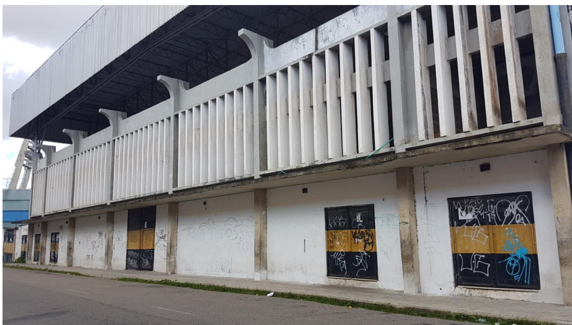
Imagem 20 – Foto tirada in loco dos portões de ferro que dão acesso à rua. Fonte: COPROJ-SEINF.
