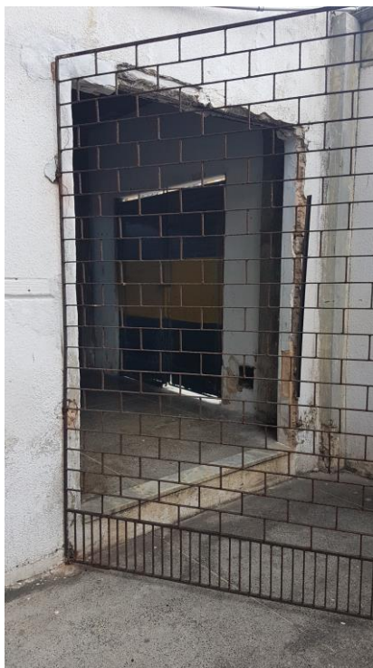
Imagem 19 – Foto tirada in loco do portão/gradil de ferro. Fonte: COPROJ-SEINF.
